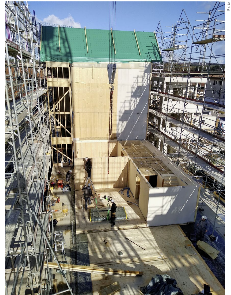
Monteure arbeiten am Dorf im Dorf: Mitten in der Zürcher Landgemeinde entsteht aus den vorgefertigten Holzmodulen, die mit Strohballen gefüllt sind, eine kompakte nachhaltige Siedlung.
