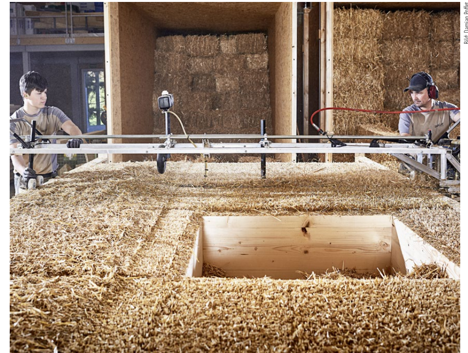
Kreative Lösung: So wird bei der Modulproduktion das gepresste Stroh im Holzrahmen beschnitten.
